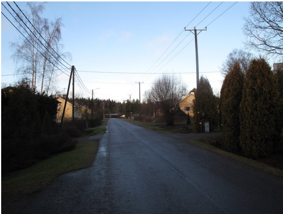
Kuva 8. Asuintaloaluetta Suitturin teollisuusalueen länsipuolella. Pohjoiskoilliseen.
